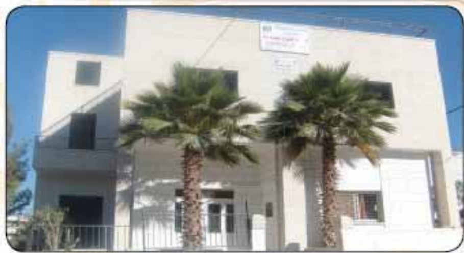
مبنى العيادة الصحية - سقف وتشطيب الطابق الثاني
